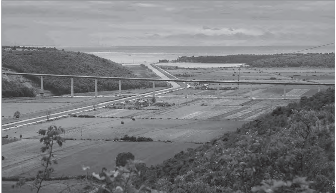
Fig. 6. Il Porto Quieto oggi, con il canale e il moderno viadotto.
