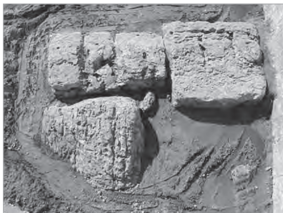
Fig. 3. Pesaro, Viale dei Partigiani: struttura muraria in opera cementizia con pali e travi di legno incorporati nella gettata.
