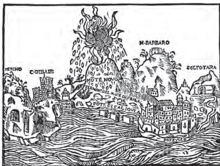
Fig. 1. Anonimo del XVI sec.; xilografia con riportata l'annotazione "terme del mare de prima" ed una imbarcazione resa grossolanamente sulla spiaggia.
