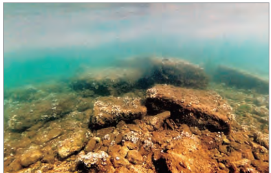
Fig. 66: Muggia. Stramare (n. 16). Particolare della gettata di blocchi a protezione del terrazzo inferiore, oggi sommerso (foto Naukleros).
