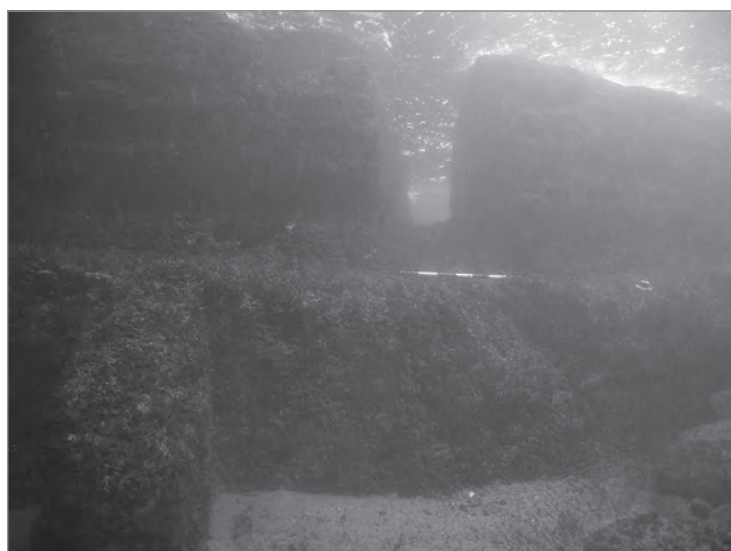
Fig. 3. Miseno, peschiera. Veduta dall'interno della vasca della crepidine e della galleria di collegamento con l'esterno.
